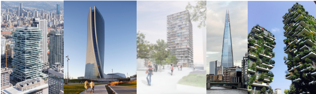
Imágenes de izquierda a derecha: Terrazas Beirut / Herzog & De Meuron. Torre Generali / Zaha Hadid. Chêne-Bourg / Lacaton & Vassal. The Shard / Renzo Piano. Bosco Verticale /Stefano Boeri Architetti.
